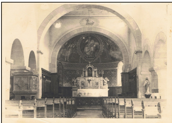
L'église avant les travaux de restauration
